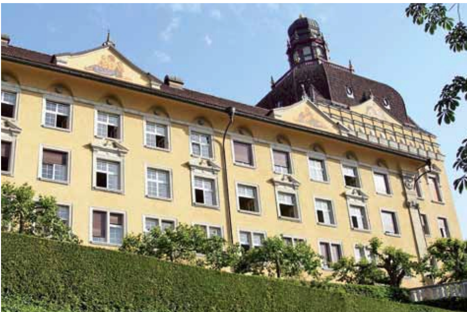
Der Hauptsitz der Suva in Luzern. Sie versichert rund die Hälfte der Schweizer Arbeitnehmenden. Ist ein Unfallversicherer leistungspflichtig, sind die Verunfallten gut geschützt. Foto: Suva
