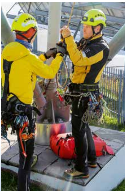
Zwei Retter verankern das Seil, an dem der Verletzte heruntergelassen wird, an einem Pfeiler des Masts.
