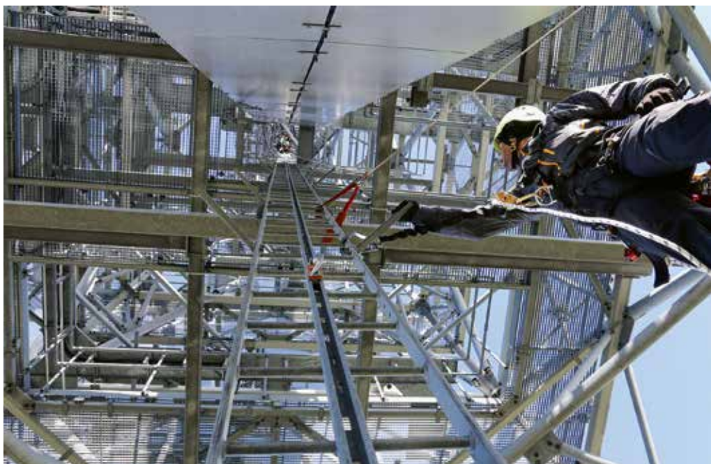
Durch diesen schmalen Schacht muss er kommen: Rettungen von Sendemasten herunter haben ihre eigenen Tücken.
